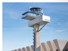
③ Neuer Tower der deutschen Flugsicherung
