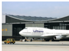
④ Lufthansa jumbo hangar
